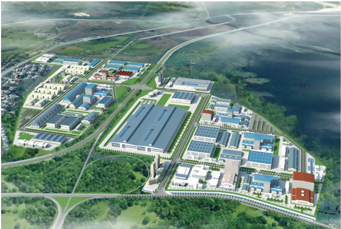
Parque industrial de ViMariel, primer concesionario de la ZED Mariel, en construcción. Industrial Park ViMariel of ZED Mariel, in construction.
